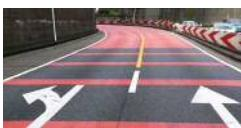
施設接触事故が特に多いカーブ区間の舗装を赤くしています。
