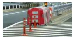
分岐部での衝突の衝撃を緩和し重大事故を防止する目的で設置しています。
